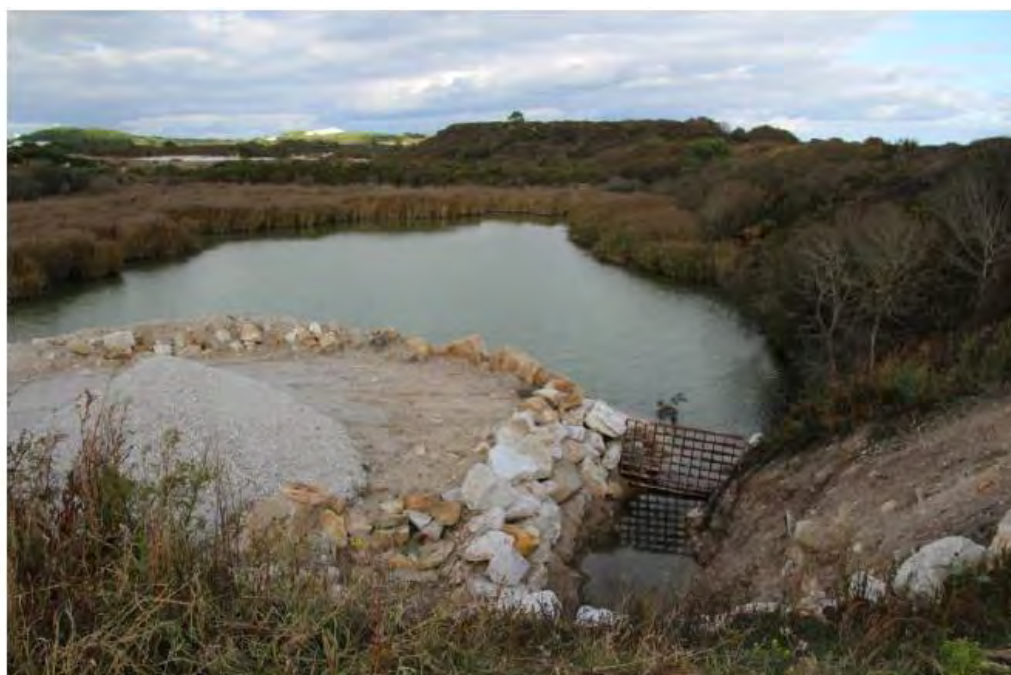
Figure 63. Exutoire sud du site avant passage sous la RD 152
